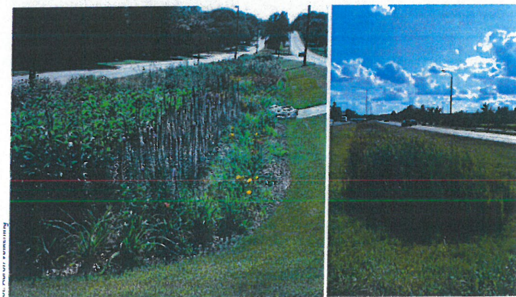
Zdj. 9. Przykładowe zdjęcie rowu bioretencyjnego (Błękitno-zielona infrastruktura dla łagodzenia zmian klimatu w miastach 2019 str. 16)
